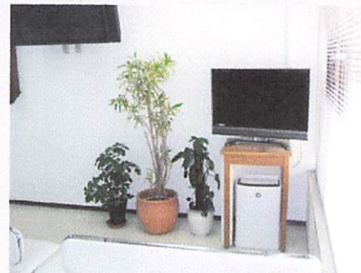
②1階外来ロビーに加湿器を設置
